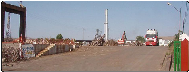
Proceso de derrumbe de la antigua fundición.
